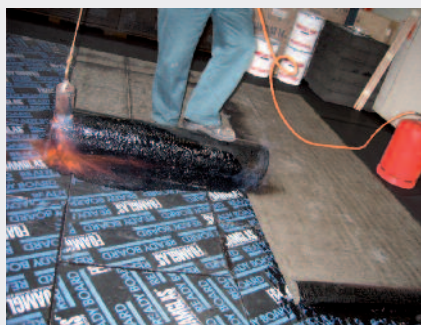
FOAMGLAS® READY BOARD, collage à froid et étanchéité soudable
