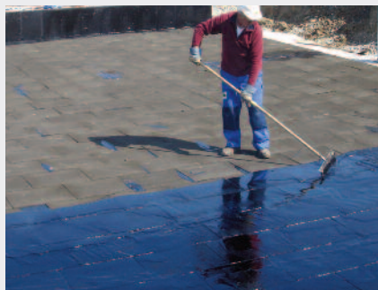
Collage à chaud des plaques FOAMGLAS® (bain de bitume)
